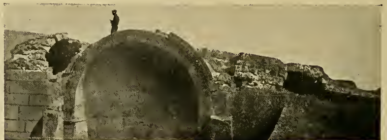
Abb. 427. Ereruk, Basilika: Steigende Tonnen der östlichen Seitenräume.
