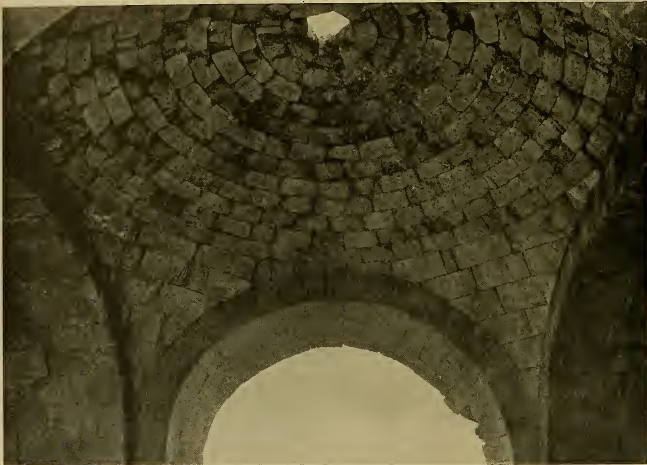
Abb. 397. Dscherasch, Thermen: Hängekuppel.
