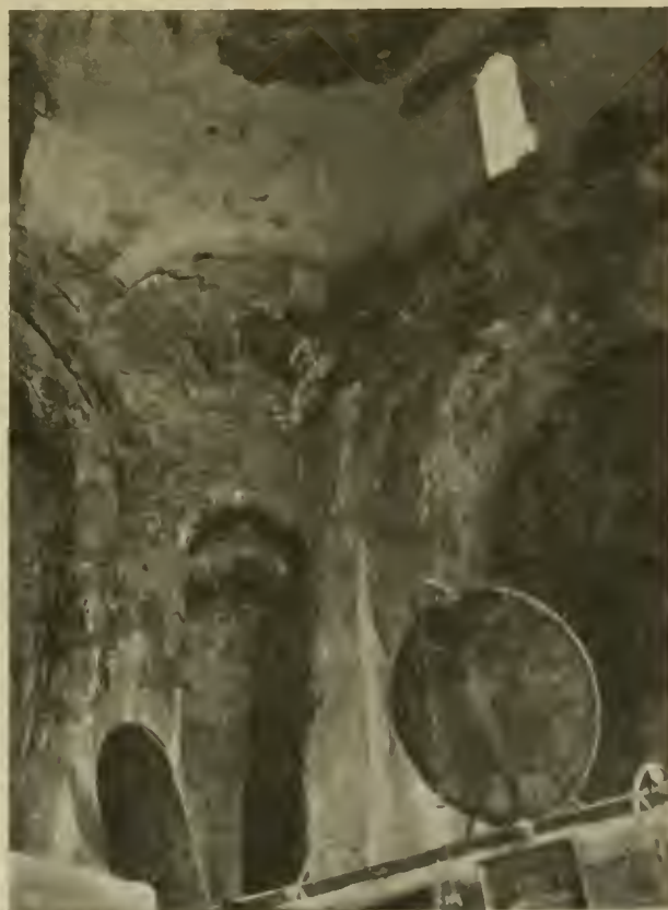
Abb. 70. Mtschet, Kreuzkirche: Trichternische in der Nordost-ecke des Grundquadrates.
